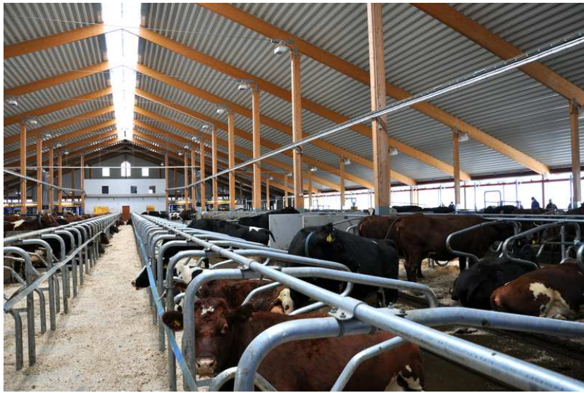
Figur 22. Interiör i modern lösdriфтsladugård med öppningsbara väggar och tvärventilation.
