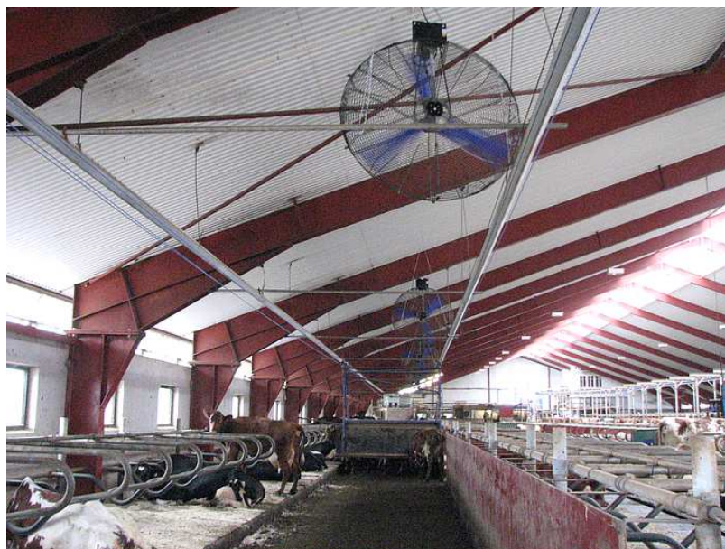
Figur 35. Svalkningseffekten beror på lufthastigheten. Avkylningseffekt som funktion av lufthastigheten kring djuren. Egen beräkning.
