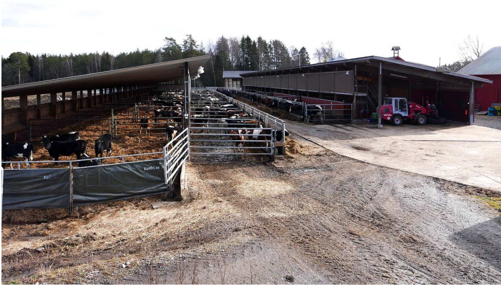
Figur 13. Exempel väderskyddande stall för slaktnöt med stora hårdgjorda ytor under bar himmel där djuren gödslar och gödseln skrapas till lagringsbehållare.
