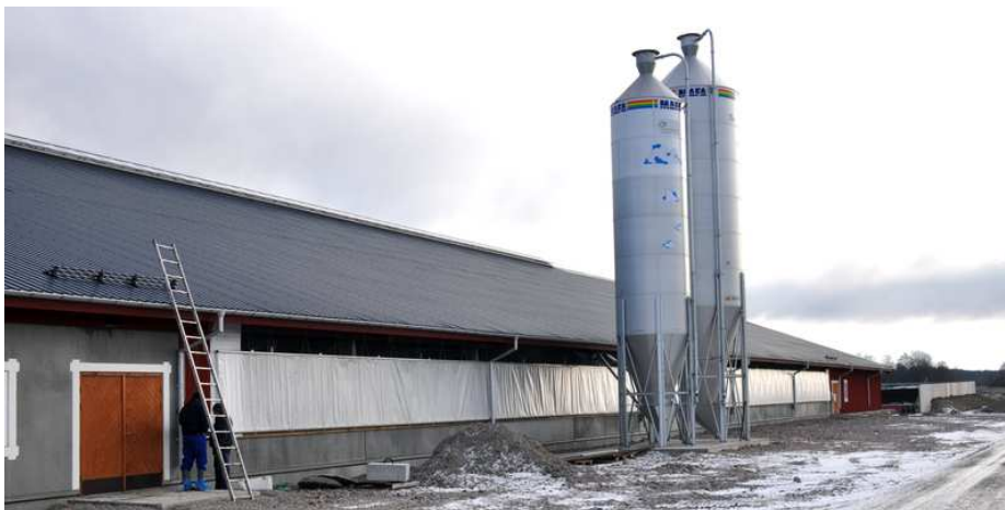
Figur 21. Exempel på modern lösdriftsladugård med öppningsbara väggar och tvärventilation.
