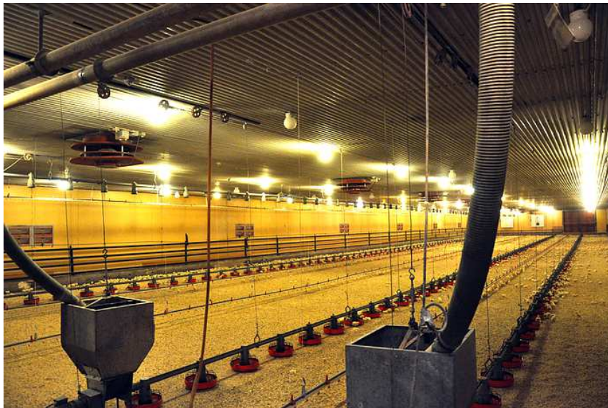
Figur 32. Interiör från slaktkycklingstall med nyinsatta kycklingar. Värmekonvektorrör längs väggarna.
