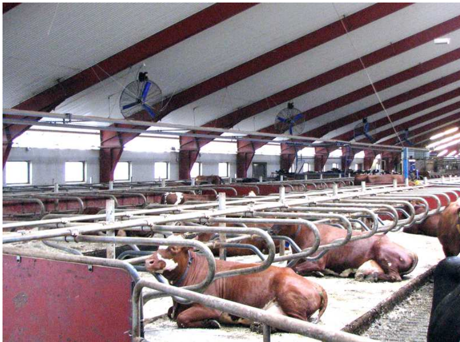
Figur 33. Mjölkstall med svalkningsfläktar i taket.
