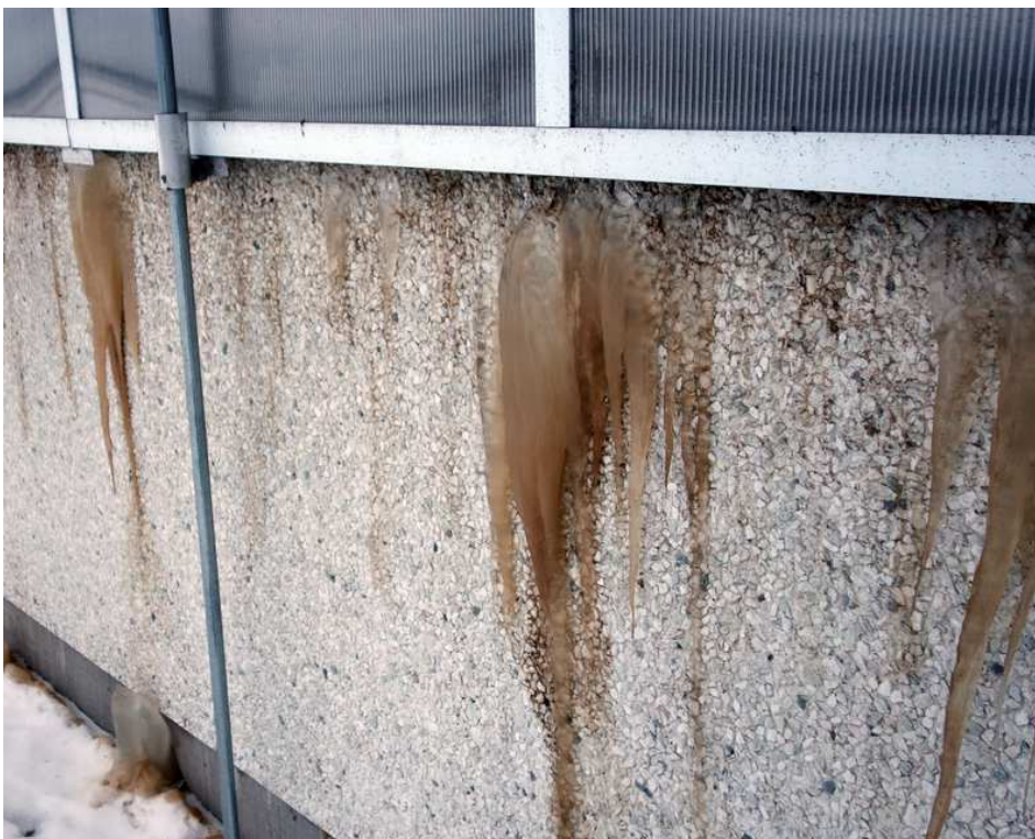
Figur 18. Exempel på påfrysning och mögelskador i klimatreglerat stall.
