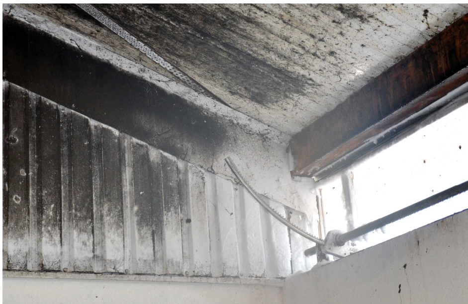
Figur 18. Exempel på påfrysning och mögelskador i klimatreglerat stall.
